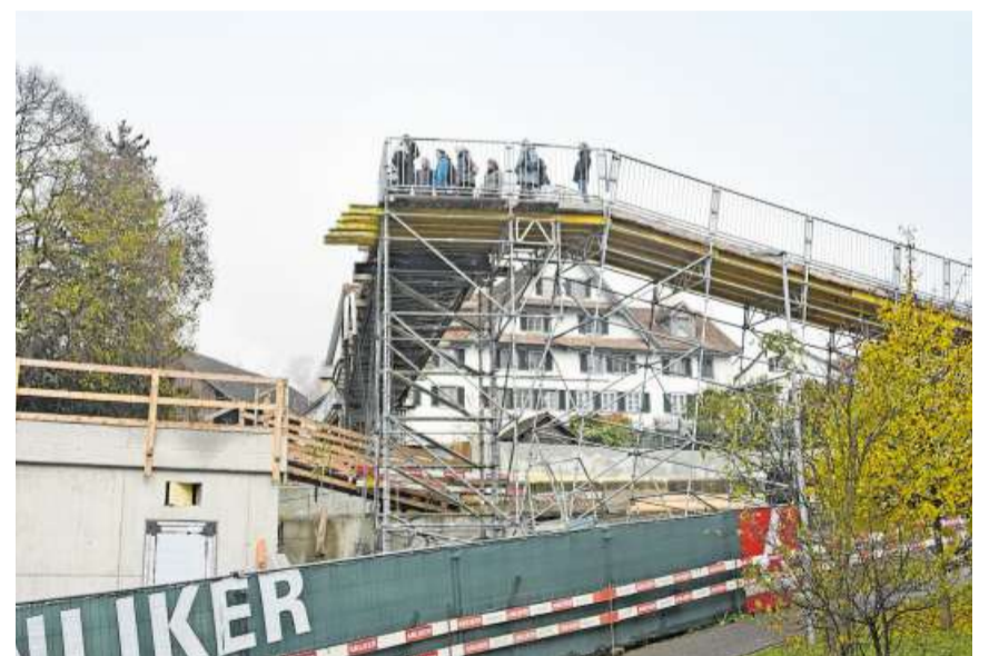
Die «LaMarotte»-Wandergruppe begutachtet die Baustelle des Autobahnzubringers durch Bickwil von der Passerelle aus. (Bild Erika Schmid)
