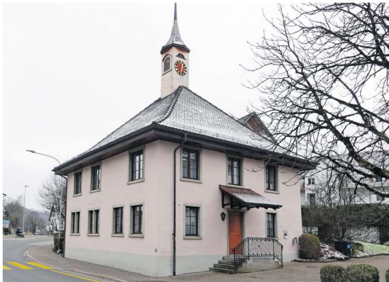
Das Wettswiler Türmlihaus wurde ab 1782 mit dem Geld der Schützen als erstes Schulhaus gebaut – in einer Zeit, als die Kinder andernorts meist in der privaten Stube des Schulmeisters unterrichtet wurden. (Bild Bernhard Schneider)
